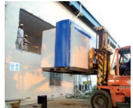
Selbst eine Betonwand im ersten Obergeschoss war kein Hindernis für die METAPLAS-DOMINO.
