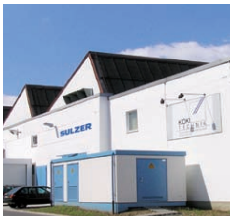
Enge Verbindung: Die Sulzer Metaplas Niederlassung ist direkt an die Produktionshalle von KOKI TECHNIK angegliedert.
