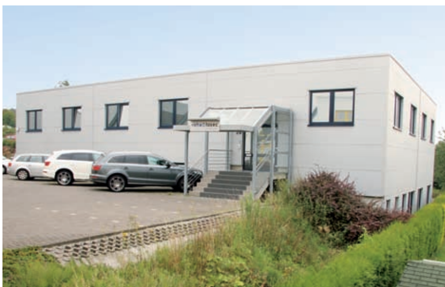
Verwaltungsgebäude von Voha-Tosec in Lindlar bei Köln
